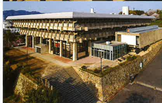
津山文化センター (川島甲士建築設計研究所 1965 DOCOMOMO JAPAN 選定建築物)
